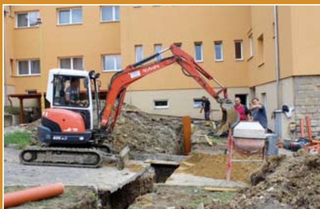
připojení staré budovy na kanalizaci
