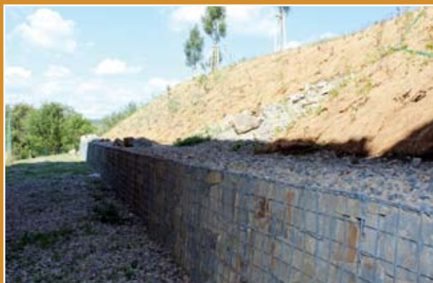
gabionová opěrní zeď
